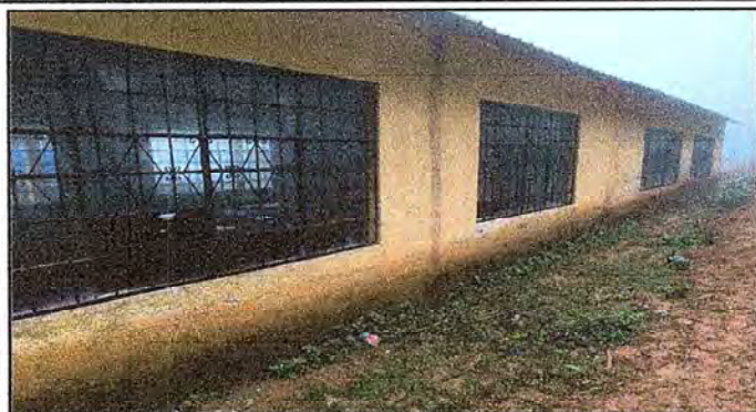
Foto1: TERMINACION DE COLOCACION DE BALCONES
