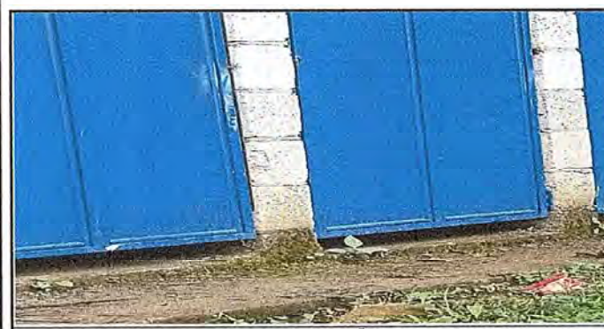
Foto 5: SUSTITUCION DE PUERTAS DE BAÑOS DE LA ESCUELA
