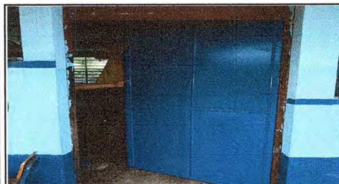
Foto 3: SUSTITUCION DE PUERTAS DE CADA UNA DE LAS AULAS
