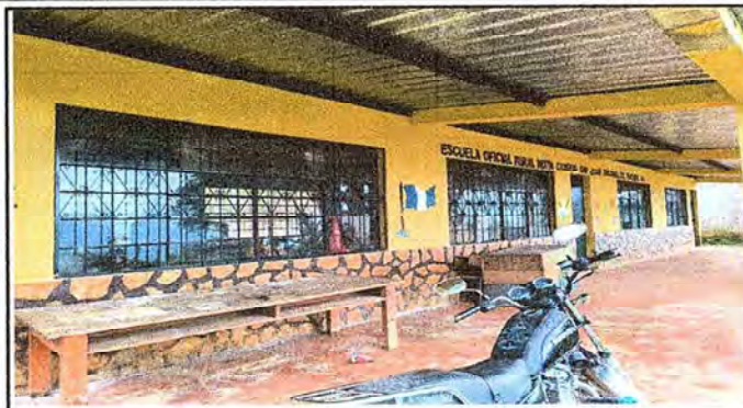
Foto 2: CULMINACION DE COLOCACION DE BALCONES DEL ESTABLECIMIENTO
