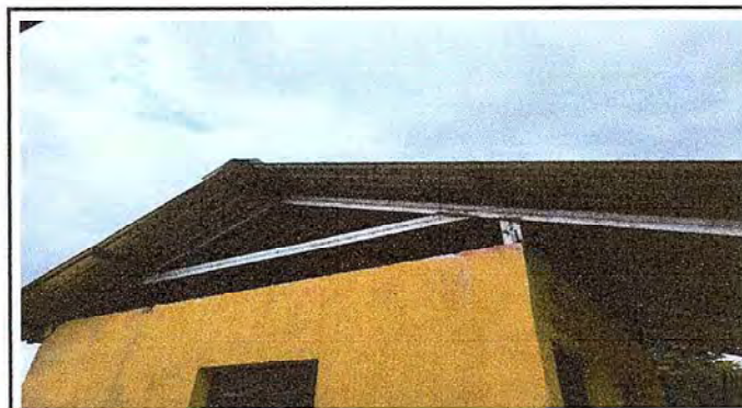
Foto 4: SUSTITUCION DE ENTECHADO DE LA COCINA
