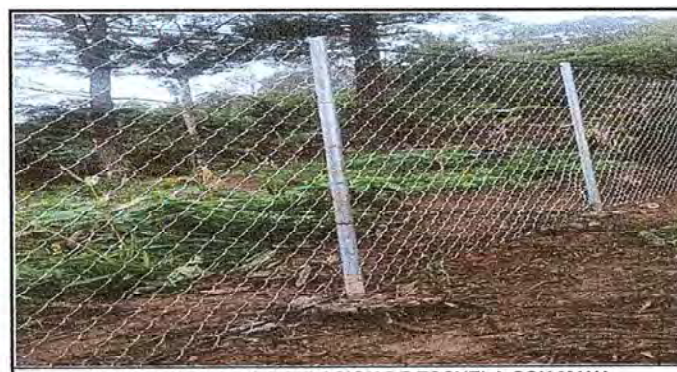
Foto 6: SUSTITUCION DE CIRCULACION DE ESCUELA CON MAYA
